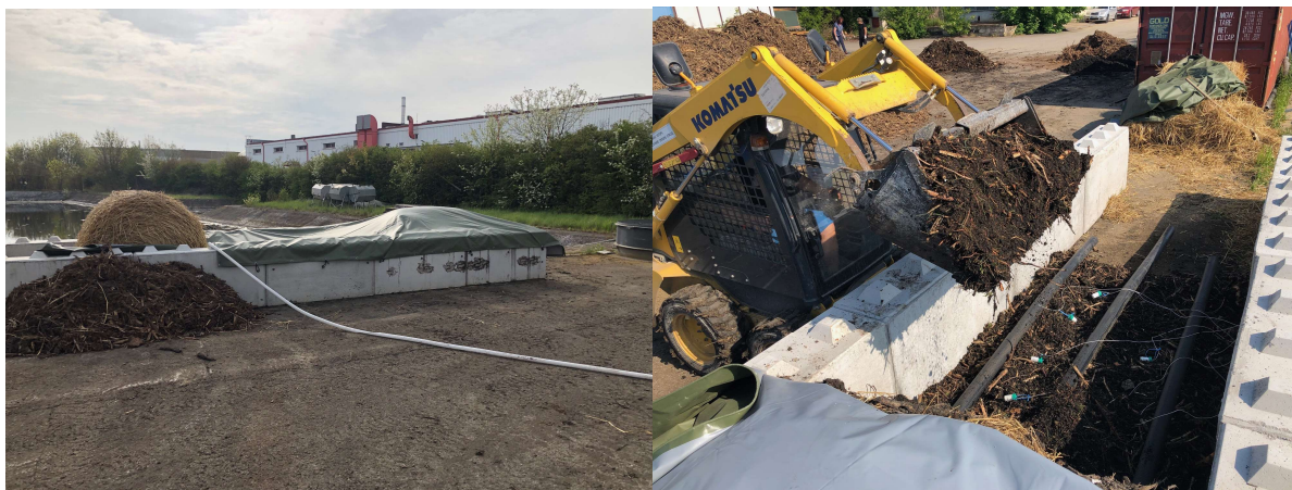
Obrázek 8 a 9: Poloprovoz „wedge“ systému vermikompostování na dekontaminační ploše Slaný a příprava zakládky – zasypávání provzdušňovacích trubek a patron s indikátorovým mikroorganismem
